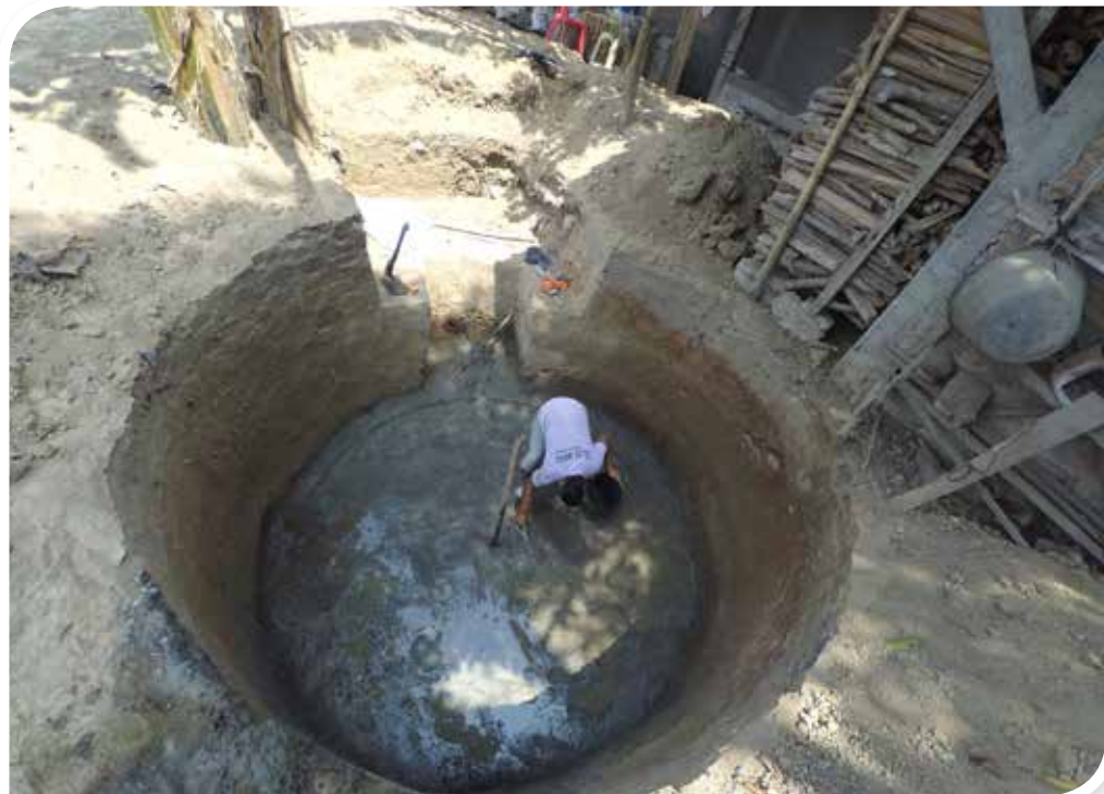
Penggalian lubang untuk reaktor Biogas Rumah (BIRU) / Digging hole for domestic biogas (BIRU) digester.
