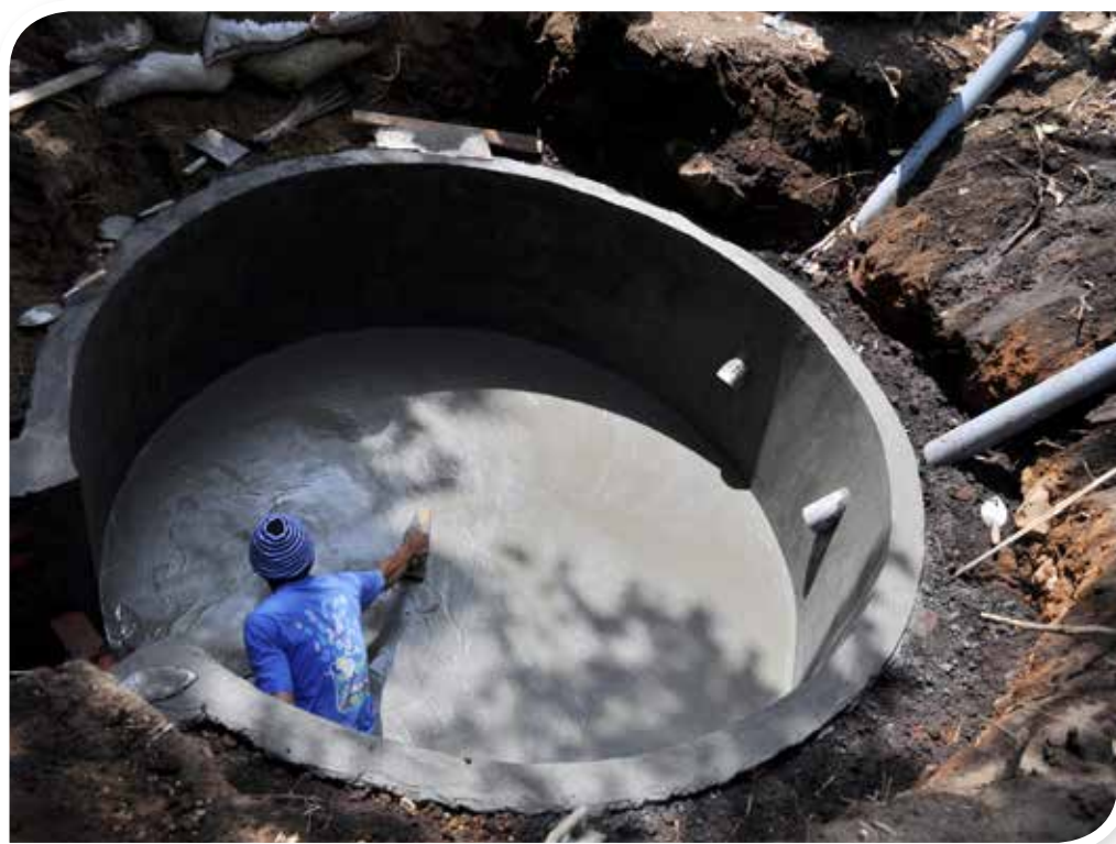
Konstruksi reaktor Biogas Rumah (BIRU) / Construction of domestic biogas (BIRU) digester.
