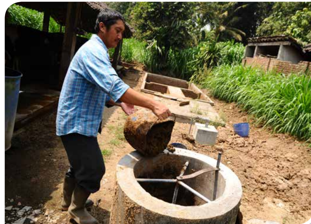
Pengisian kotoran hewan sebagai bahan utama reaktor Biogas Rumah (BIRU) / Animal dung is poured as the ingredients of domestic biogas (BIRU).
