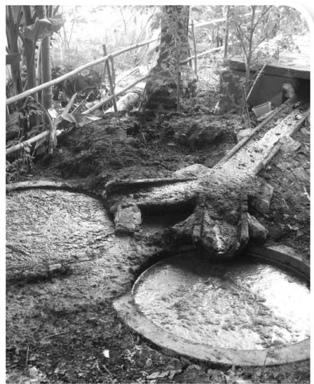
Lubang/bak penampung *bio-slurry* yang ideal memiliki dua buah bak penampung.
