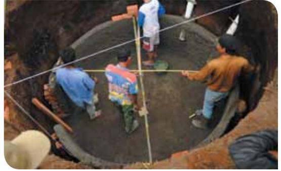
Memplaster dinding melingkar reaktor dengan menggunakan perbandingan 1 semen : 4 pasir
