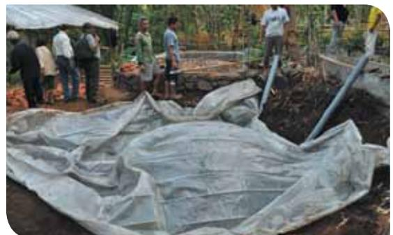
*Proses pengecoran kubah - jika pembangunan reaktor pada musim hujan selalu sediakan terpal atau plastik untuk menutup bagian atas kubah yang telah dicor*
