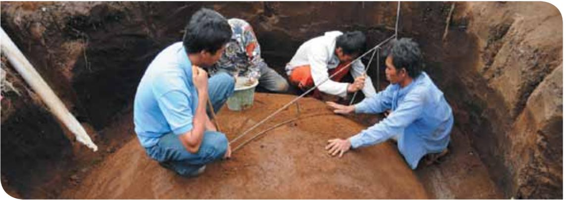
*Cetakan kubah dibentuk dari tanah yang dipadatkan dengan bantuan alat cetak kubah yang terbuat dari besi.*
