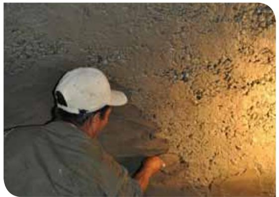
*(Searah jarum jam) Proses pencampuran semen dan pasir, mengikis dinding bagian dalam kubah, memberikan lapisan dinding bagian dalam kubah*
