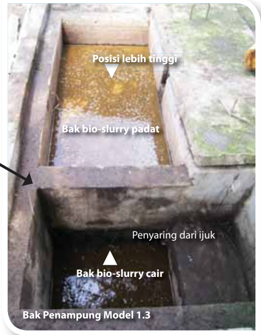
Gambar macam lubang/bak pemisah slurry.
