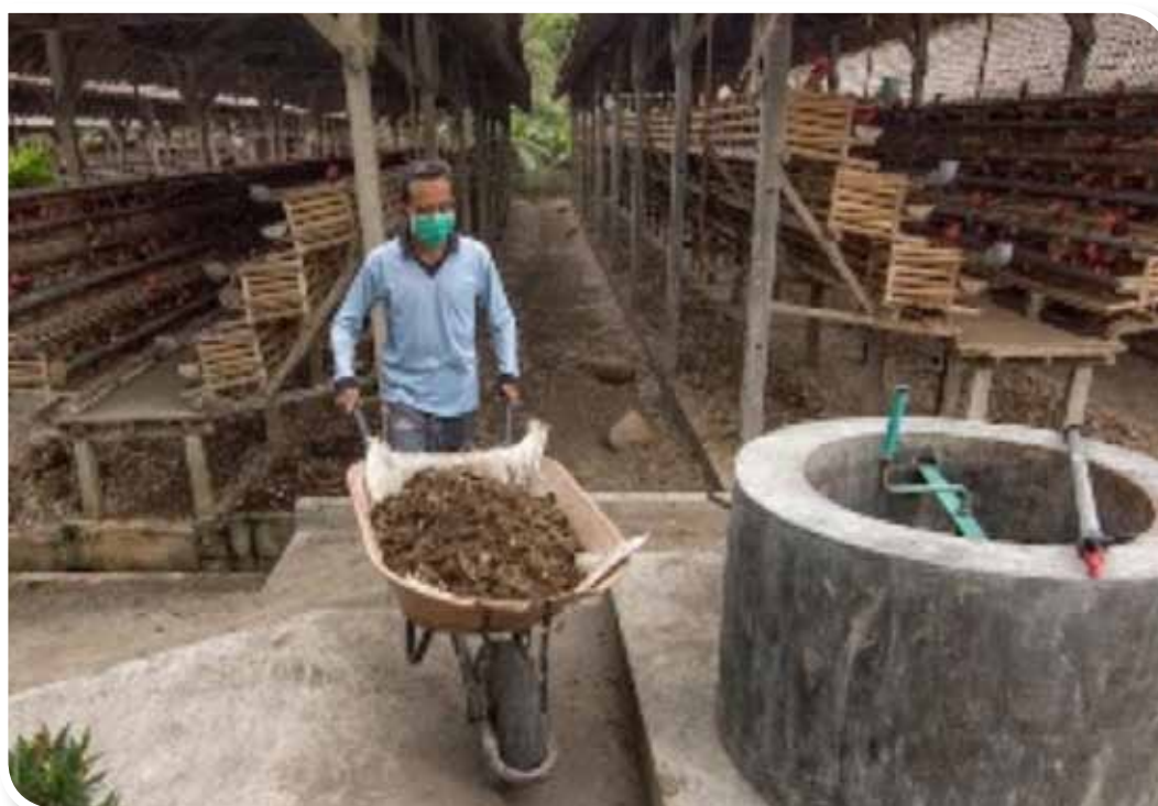
Pengguna BIRU di Blitar memanfaatkan kotoran ayam petelur sebagai bahan biogas
