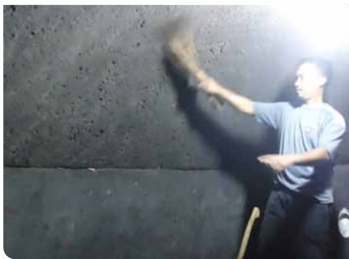
Seorang tukang sedang menyelesaikan pembangunan kubah reaktor di Jawa Tengah
