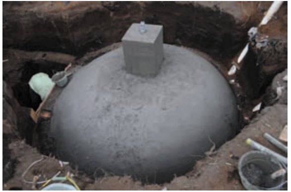
(Searah jarum jam) 1. Proses pencampuran semen dan pasir, 2. Mengikis dinding dalam kubah. 3. Kubah yang sudah jadi, 4. Proses pembuatan menara kecil.
