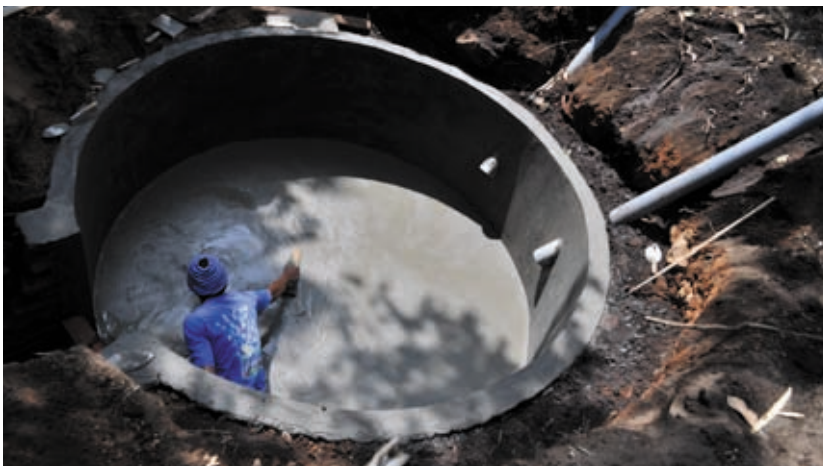
Bentuk dinding melingkar yang sudah jadi.
