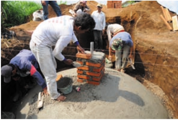
(Searah jarum jam) 1. Proses pencampuran semen dan pasir, 2. Mengikis dinding dalam kubah. 3. Kubah yang sudah jadi, 4. Proses pembuatan menara kecil.
