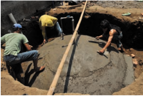
Proses pengecoran kubah.
