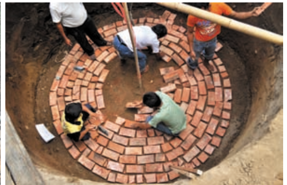
Penggalian tanah dan peletakan batu bata yang berjarak satu sama lain.
